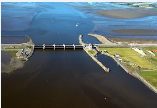
Das Eider-Sperrwerk aus der Luft. (Die kleinen weißen Punkte im Vordergrund markieren die Sperrkette) Bildvermerk: WSA Tönning
